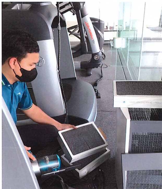
รูปภาพที่ 30 มีการติดตั้งเครื่องฟอกอากาศในห้องออกกำลังกาย โดยดำเนินการเปลี่ยนไส้กรองทุกๆ 6 เดือน และมีเจ้าหน้าที่ เข้าบริการดูดฝุ่นไส้กรองเป็นประจำ เพื่อลดฝุ่นที่ก่อให้เกิดภูมิแพ้ และฝุ่น PM 2.5
